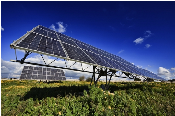
Fig. 1 - Impianto fotovoltaico a inseguitore solare (dal sito https://www.qualenergia.it/ )
