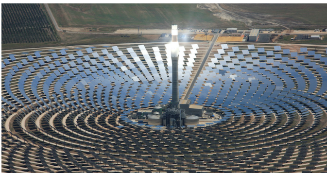
Fig. 8 - Impianto solare termodinamico (dal sito https://www.grastim.it )
