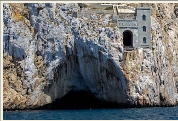
Foto 8 e 8bis: Porto Flavia, Parco Geominerario
